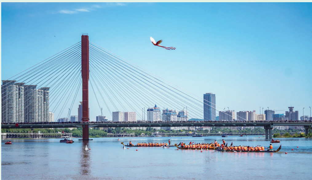
这是位于吉林市松花江上的临江门大桥(2024年6月10日摄)。
